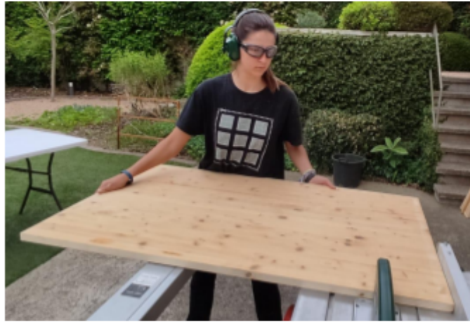
Figura 28: inici de la construcció de la Sandbox . S'estan tallant les fustes per fer la caixa de sorra. Font pròpia.
